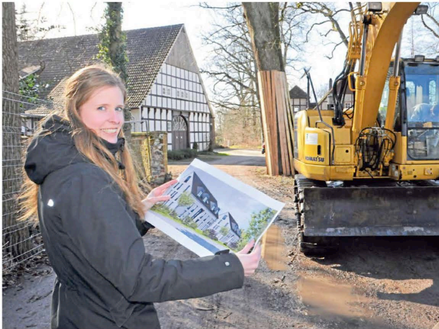
Jana Pepping vom Immobilienbüro Neugebauer hat die Projektleitung übernommen. In der Hand hält sie eine Grafik von den drei neuen Mehrfamilienhäusern, die auf dem Grundstück gebaut werden. Links ist das inzwischen denkmalgeschützte ehemalige Wohnhaus der Familie König zu sehen.
