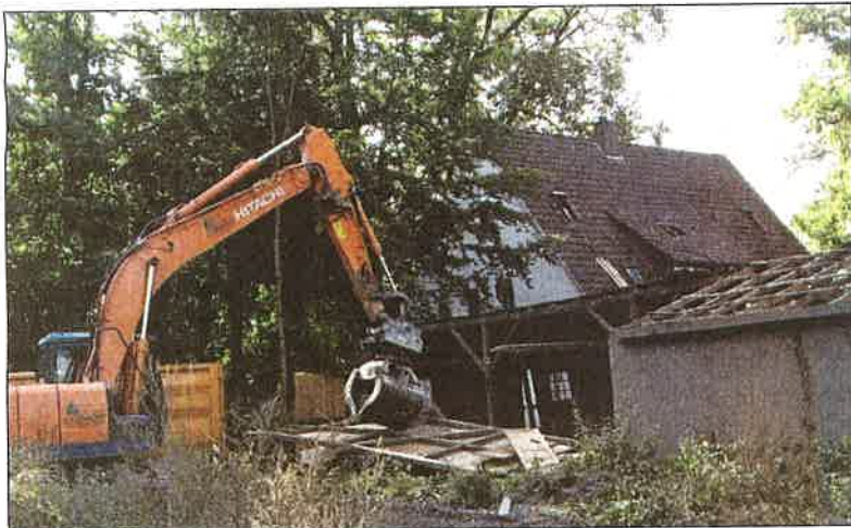
Der Holzschuppen ist am Mittwoch das erste Gebäude, das abgerissen wird. Das alte Wohnhaus dahinter steht noch.
